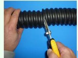
らせん状になった切断部を、電工ハサミにて切断して完了。
