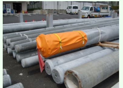
⑥穴に赤旗を捕縛して取付け完了。 (一人でも取付け可能)
