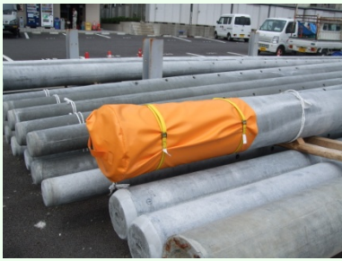
④締め付けた端尺ベルトを処理して取付け完了。
