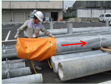
②電柱元に撤去電柱運搬シートを被せる。
