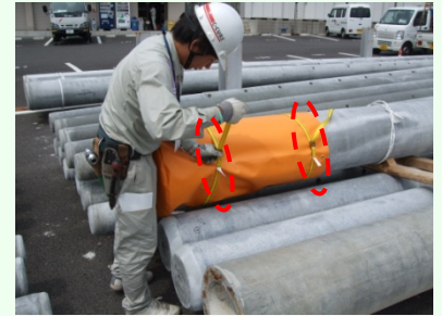
③撤去電柱運搬シートのズレ防止ベルトを2ヶ所締め付ける。
