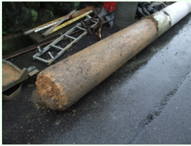
①泥砂等が付着した撤去電柱。
