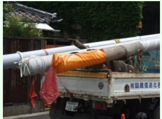
撤去電柱運搬シートを取付けて運搬。
