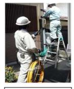
電線共同溝用多条引上げ管より通線
