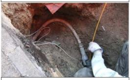
細径管にケーブルを増設の際、不通過となり 再掘削して通線を補助して通線。
