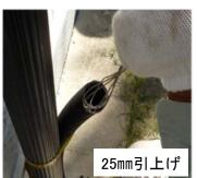
25mm可とう引上げ管 (ビル引込)での通線
