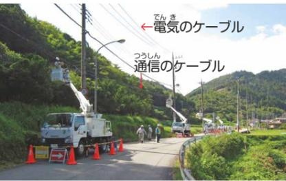
▲▲ケーブルを設置したり取り換えたりする仕事。通信用のケーブルは、電気を通すケーブルの下の方にあるよ
