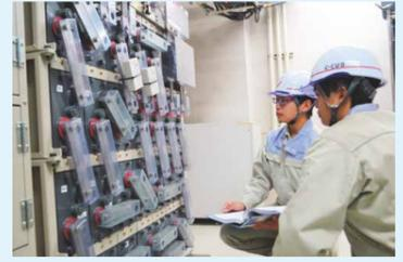
▲通信設備には電源も必須。停電した時に自動で復旧する設備など、高い技術が必要な通信電源設備の設置やメンテナンスも行っています
