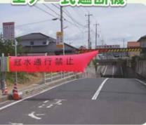
▲電車の線路や道路などの下を通るアンダーパス構造の道路は、大雨で冠水してしまうことがあります。危険な道路への侵入を防ぐため、「エア式遮断機」を設置しています。
